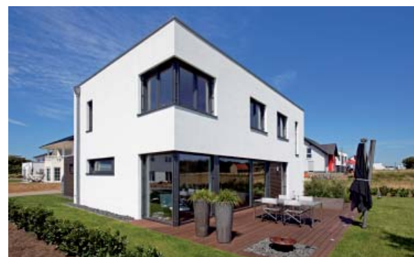
Einfamilienwohnhaus, Gießen, Deutschland
