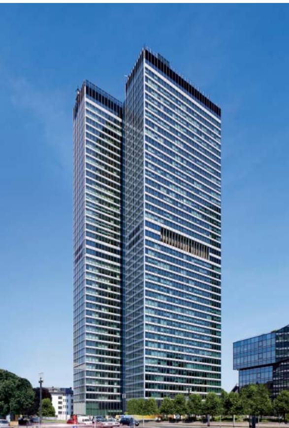
City Haus 1, Frankfurt/Main, Deutschland
